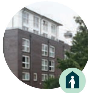
Hemmstrasse 345 A, Bremen.
